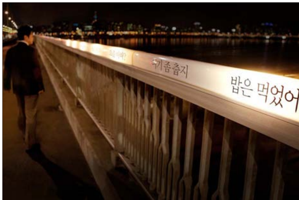
Автоматическая подсветка на перилах моста
